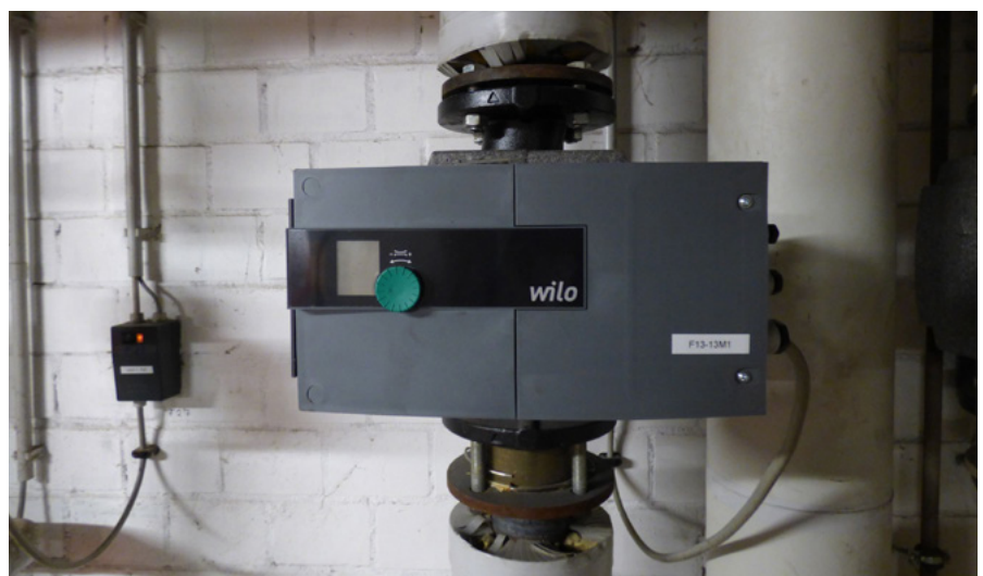
Die alten Heizungspumpen wurden durch diese Hocheffizienzpumpen ersetzt
