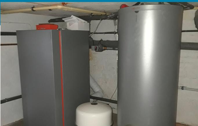
Dieser modulierende Brennwert-Heizkessel ersetzte vier alte Kombithermen.
