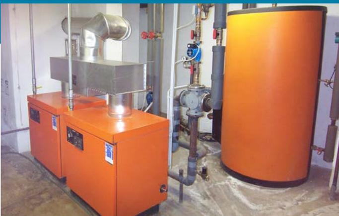
Kombination aus Gas-Brennwert-Heizung und Wärmepumpe zur effizienten Klimatisierung.
