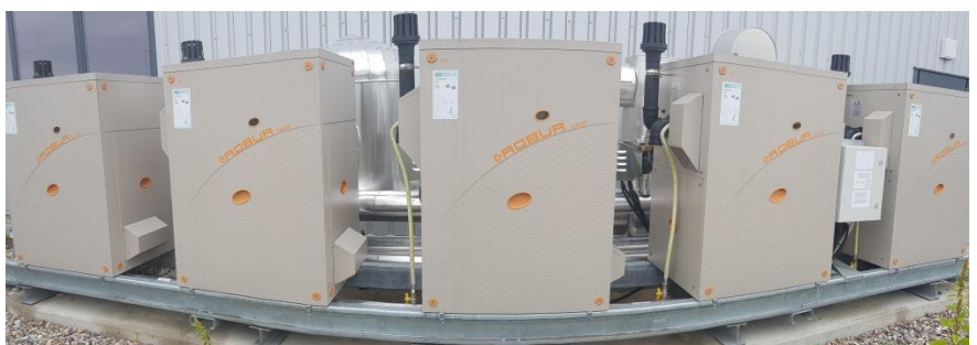
PV-Aufdachanlage (oben) und kaskadische Gas-Absorbtions-Erdwärmanlage bei der AMS (©AMS)
