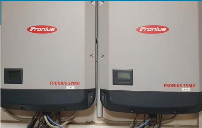
Die Wechselrichter der neuen PV-Anlage wandeln Gleichstrom vom Dach in Wechselstrom für das Stromnetz um.
