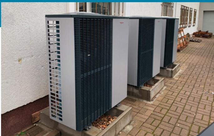
Die drei neuen Luft-Wasser-Wärmepumpen ergänzen das hybride Heizsystem.
