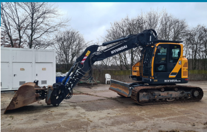
Zwei neue Kettenbagger arbeiten spürbar effizienter.
