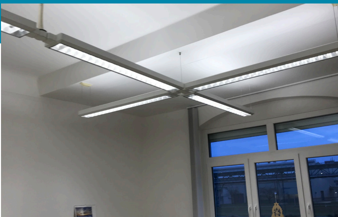
Neue Fenster und neue LED-Beleuchtung sparen Energie.
