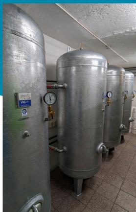
Neue frequenzgeregelte Kompressorstation für die Stickstoffanlage.
