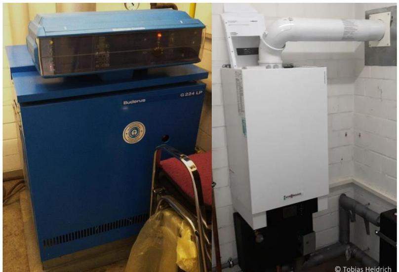
60 kW-Niedertemperaturkessel Bj. 1995 vs. 55 kW-Gasbrennwerttherme Bj. 2016
